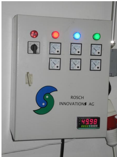
Abbildung 8 Generator Schaltschrank
